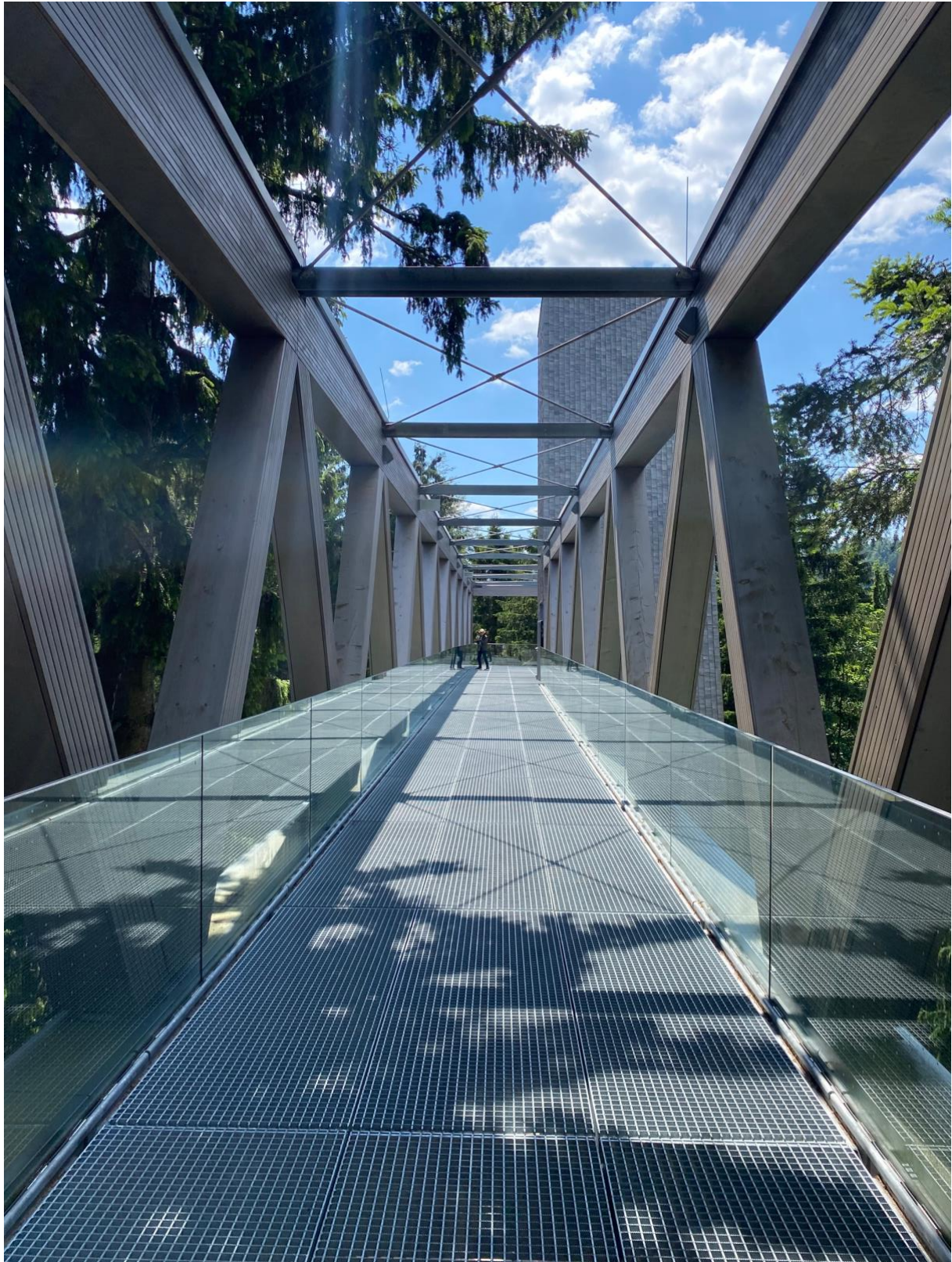
Abbildung 5: Holz-Stahlkonstruktion Brücke auf dem Weg zum Aussichtsturm des Nationalpark Zentrum.
