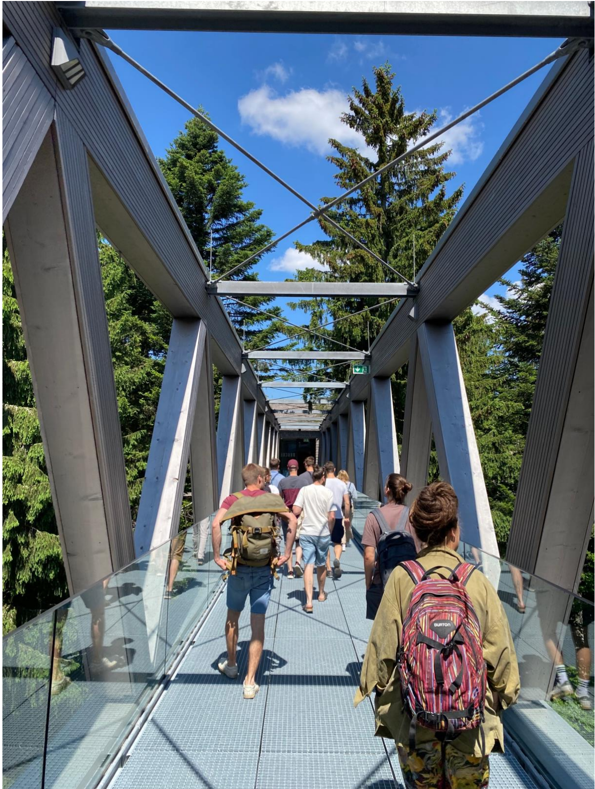
Abbildung 8: Die Masterstudenten ReBa auf der Holz-Stahlkonstruktion Brücke.
